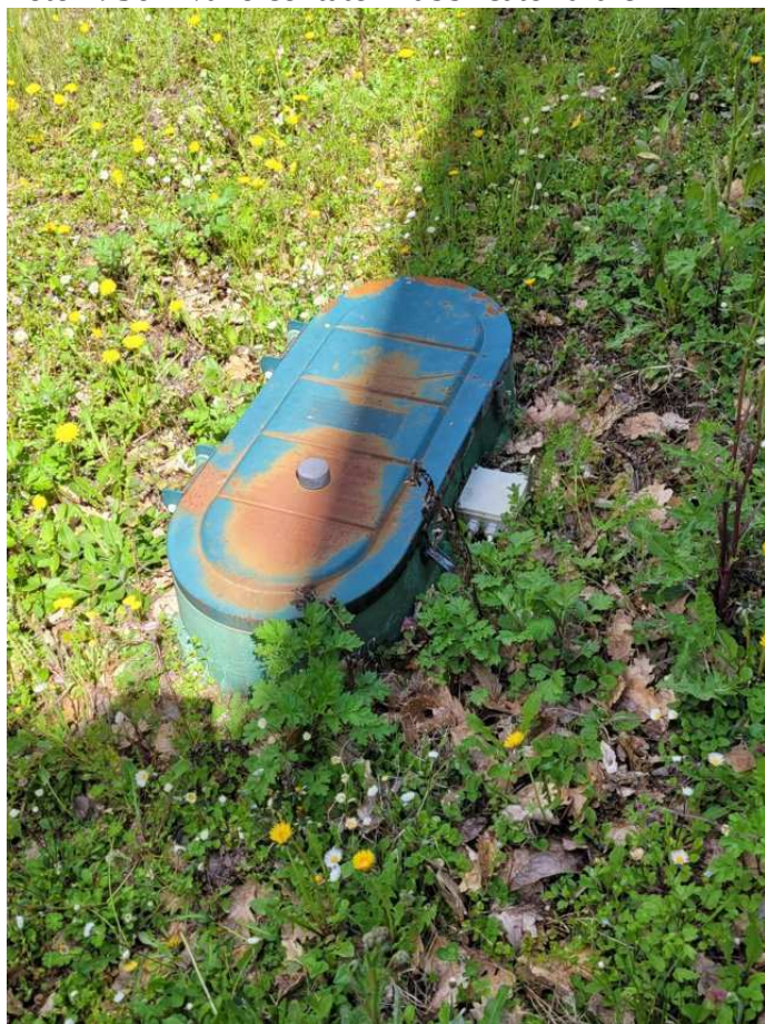
Foto n. 37 – cisterna fabbricato rurale
